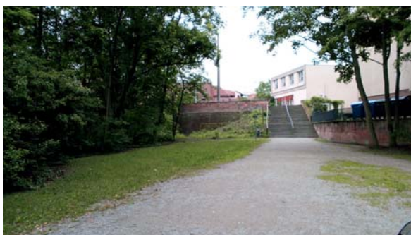
Neben der Treppe zur Hallertorbrücke erfolgt der Durchstich zur Altstadt
