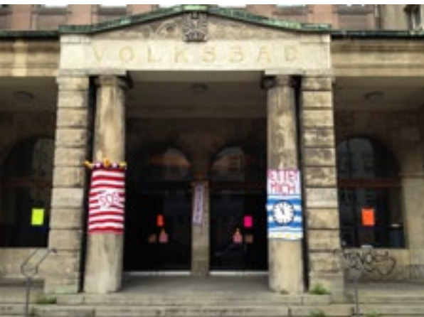
Für das Volksbad am Plärrer gibt es Hoffnung auf eine Wiedereröffnung.
