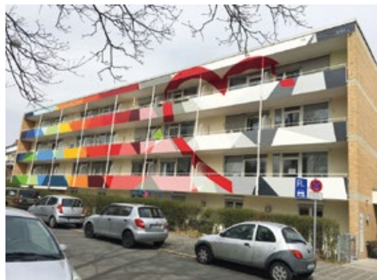
Neue Außenfassade des Käte-Reichert-Heims in Johannis ▼
